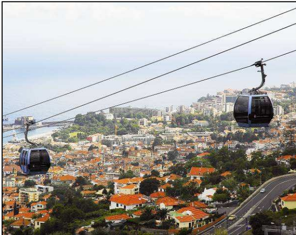
Metrocable aérien TC Funchal - Portugal
